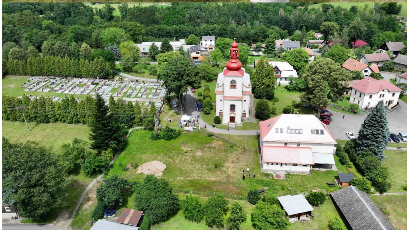
Zahájení přístavby II. stupně ZŠ Dobré-8.7.2024
