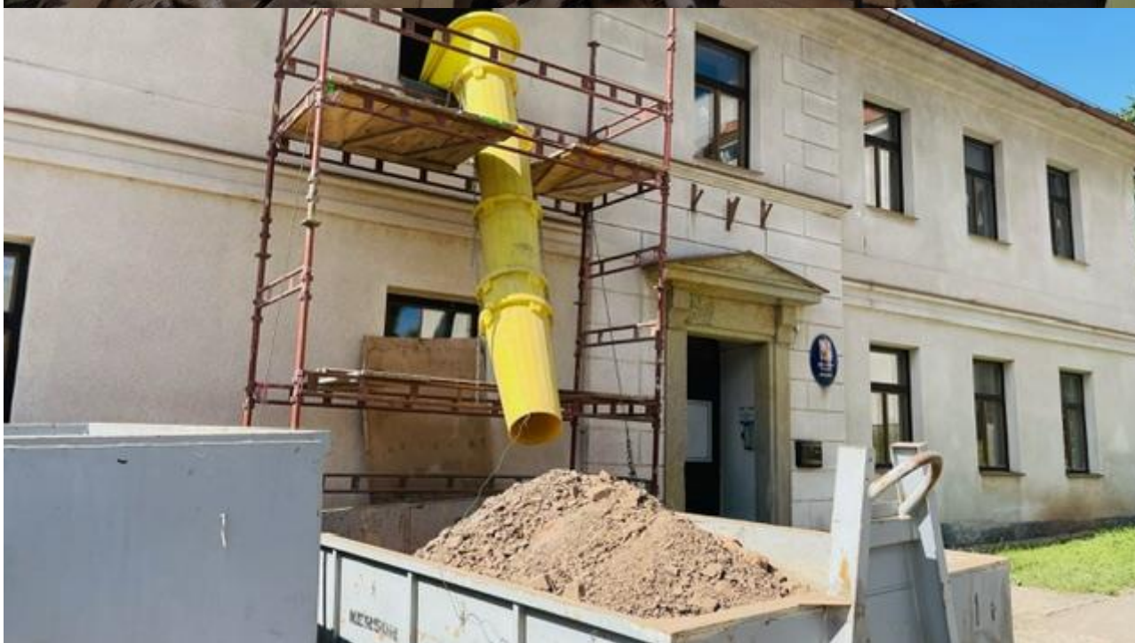
23. 06. Zahájení rekonstrukce v budově 1.st.
